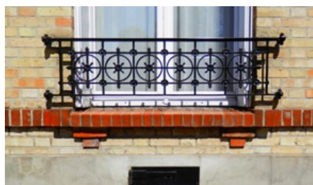
19 rue du Grand Cerf
